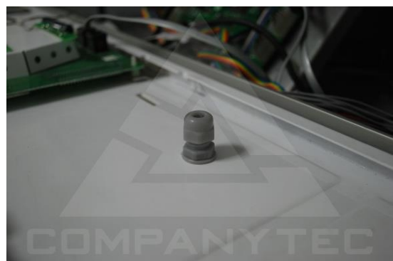
Figura 17 - Colocação do prensa cabo na chapa interna
