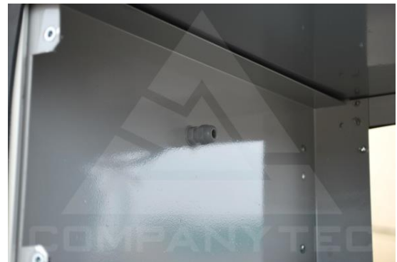
Figura 11 - Colocação do prensa cabo na chapa interna
