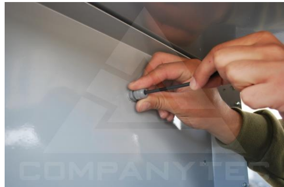
Figura 15 - Após a instalação do sensor IDF04 gire a bucha de aperto até que o cabo fique bem firme
