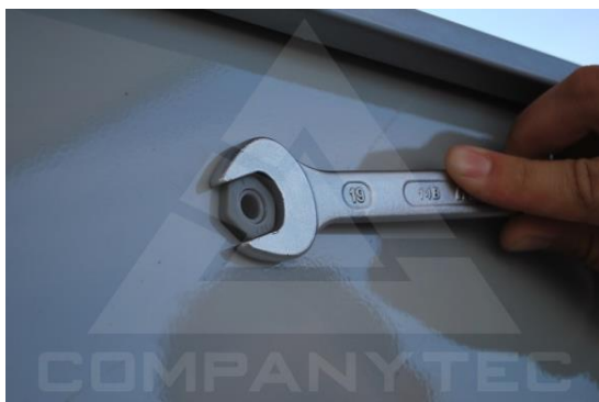
Figura 16 - Fixação do prensa cabo com contra porca entre as duas chapas
