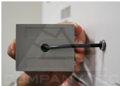
Figura 22 - Fixação do prensa cabo diretamente no equipamento
