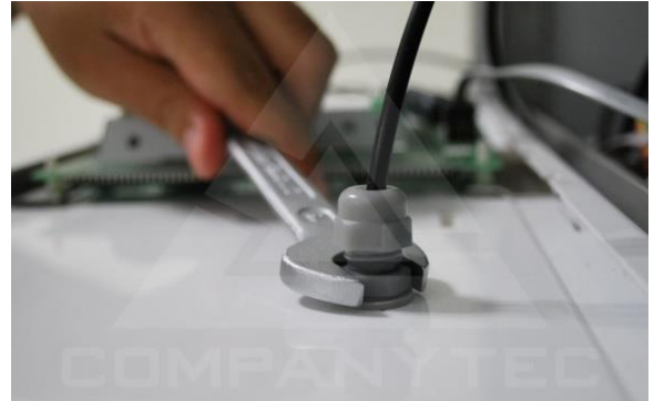
Figura 23 - Aperto do prensa cabo
