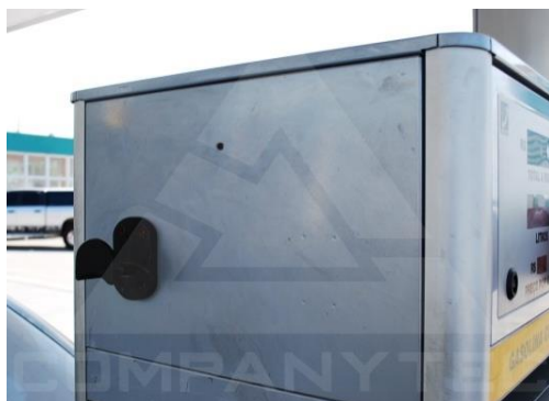
Figura 13 - Furo da chapa externa com 6 mm de diâmetro
